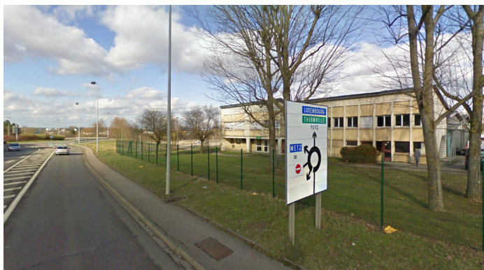
Centre AFPA : bâtiment administratif à structure béton apparente
