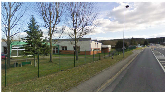
Centre AFPA : les ateliers avec toiture en sheds de type industriel
