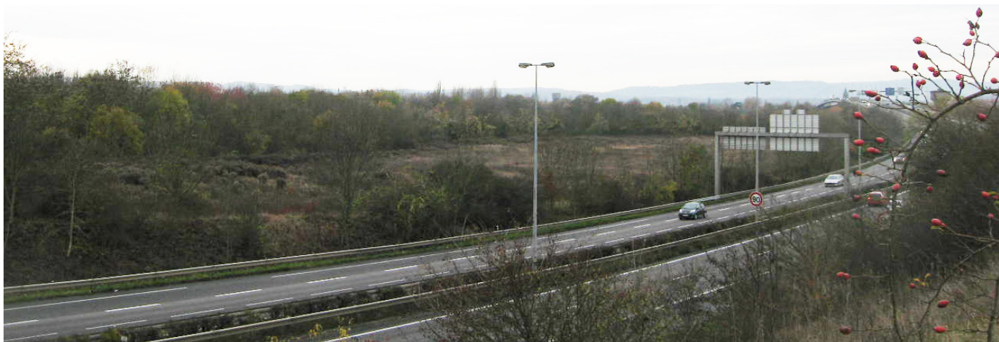
La zone 1AUYt vue depuis la RD1 (au nord de l'autoroute) en direction du viaduc de Beauregard
