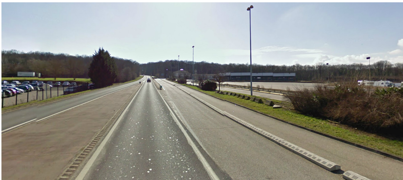
La contre-allée qui permet actuellement d'accéder à l'ancien centre de transit routier
