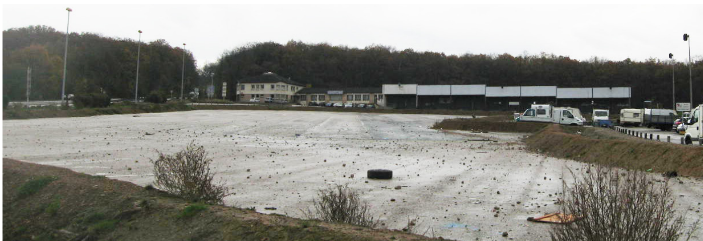
Le bâtiment des douanes vu depuis le parking du CTR. Au fond, le bois d'Illange. A gauche, la RD1.
